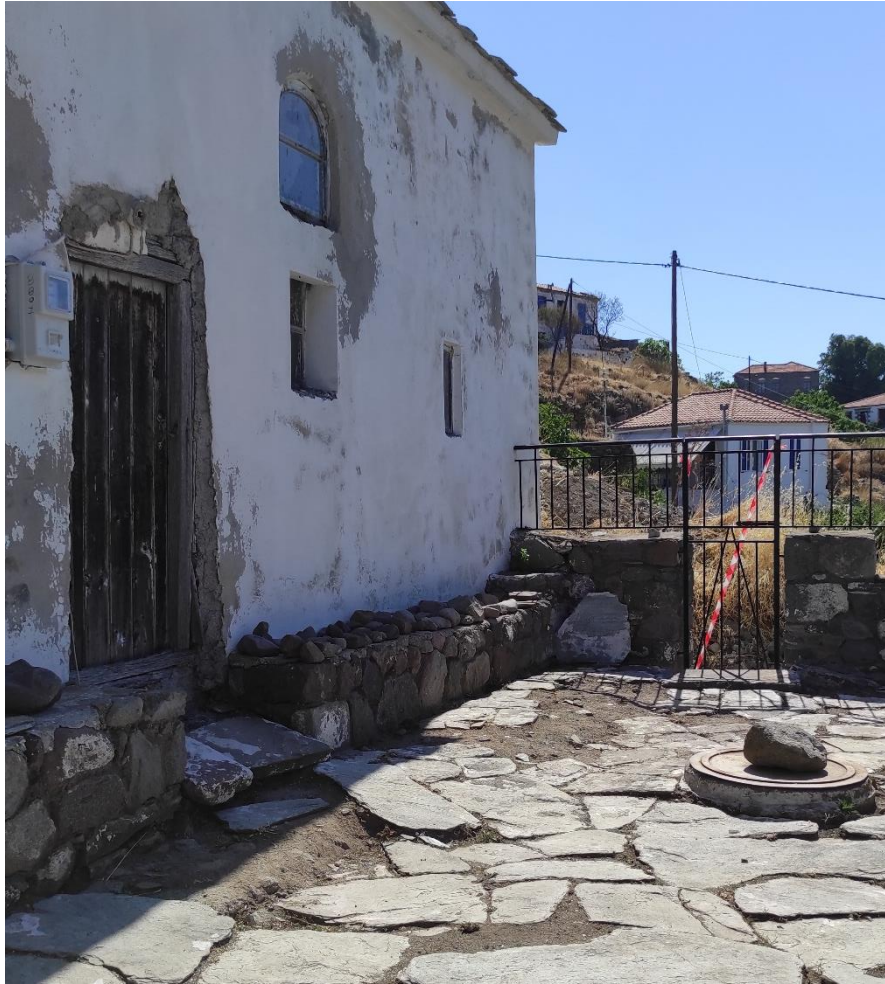
Εικόνα 3: Κατασκευή 4.1.2 πριν την καθαίρεση
