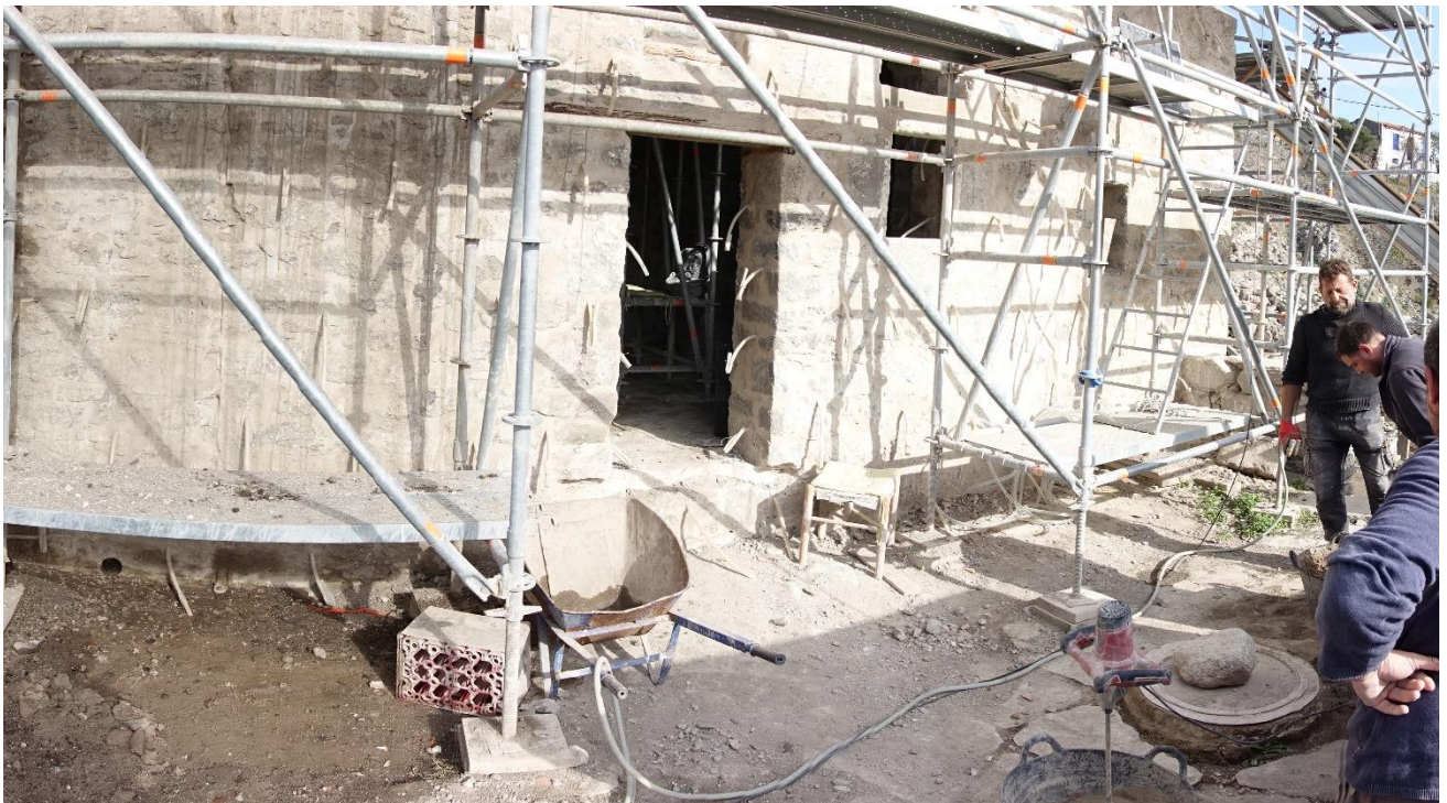
Εικόνα 4: Κατασκευή 4.1.2 μετά την καθαίρεση
